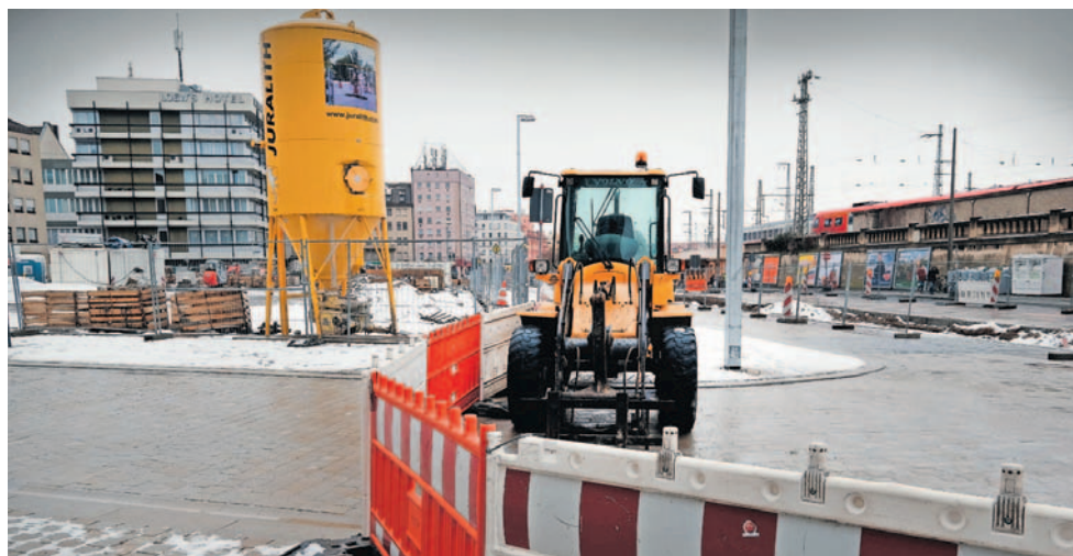
Es geht weiter: In dieser Woche beginnt der Servicebetrieb Öffentlicher Raum (Sör) mit dem zweiten Bauabschnitt auf und rund um den Nelson-Mandela-Platz. Noch ist das Areal eine Großbaustelle, in den kommenden Monaten jedoch werden die Veränderungen sukzessive sichtbar, versichert Bürgermeister und Sör-Chef Christian Vogel. Fotos: Horst Linke
