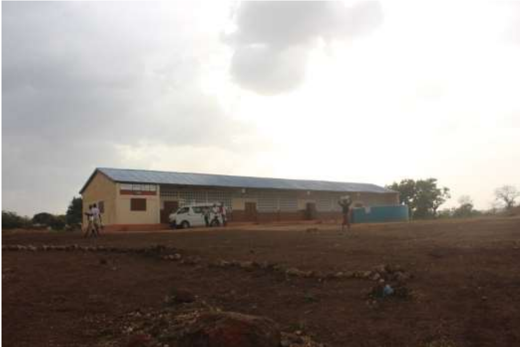
Schulbau Fi Bassar, Februar 2018
